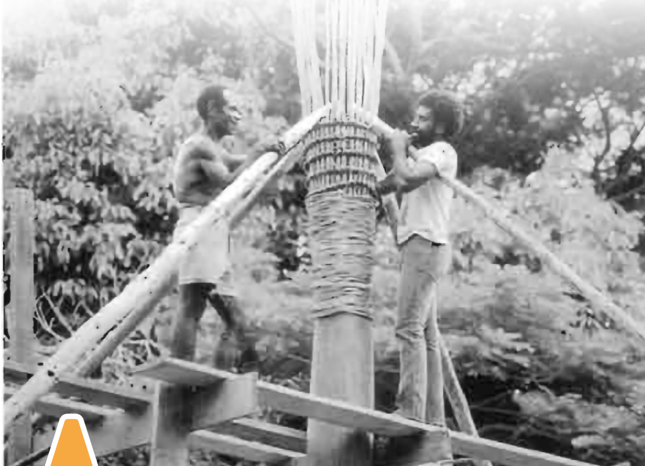
1984, deux hommes posant les chevrons sur la corbeille à Ponérihouen (Boulay, 1990).
