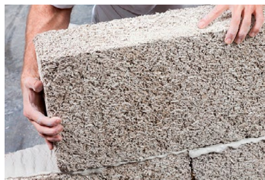
Parpaing en brique de chanvre.
