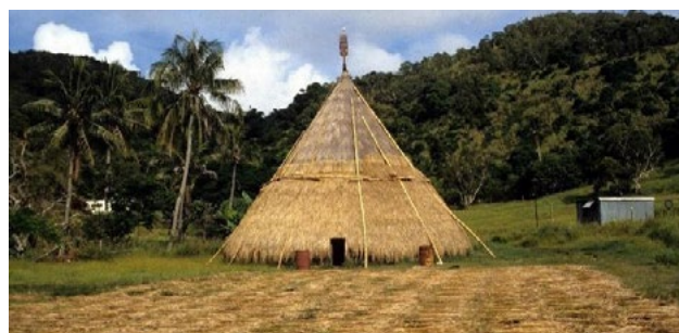
Case en construction - Grande Terre.
