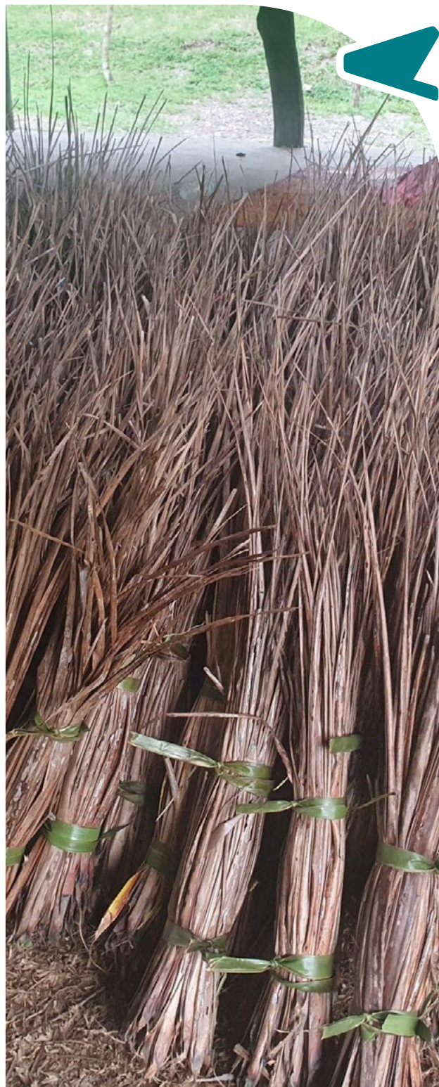
Préparation de bottes de feuilles de cocotier pour la couverture d'un faré à Maré.
