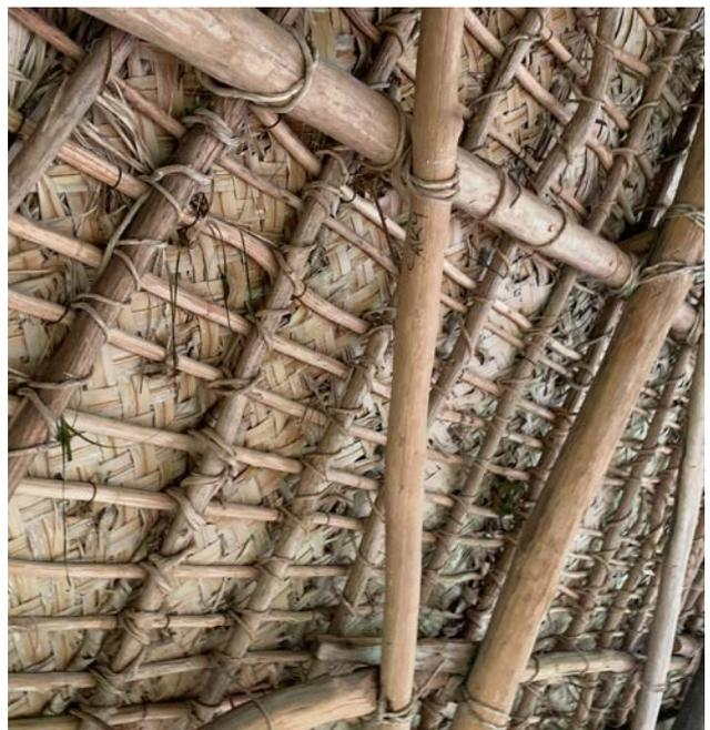
Attaches, liens, tissage, enroulages, les processus de construction de la case symbolisent les processus de construction de la cohésion sociale du clan, des liens humains. Ci-dessus, détails d'attaches de cases à Lifou et Ouvéa.
